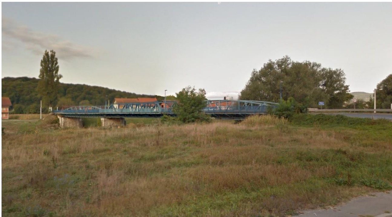
Slika 3.1 Postojeća prometnica i most preko rijeke Kupe (Izvor: Google Street View)
